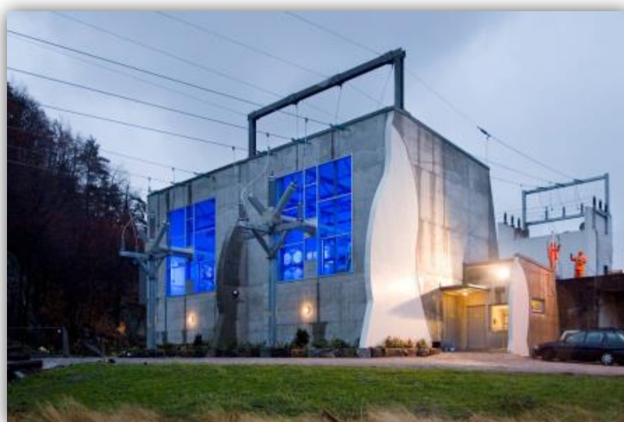
Torbjørnsbu transformatorstasjon, Arendal
